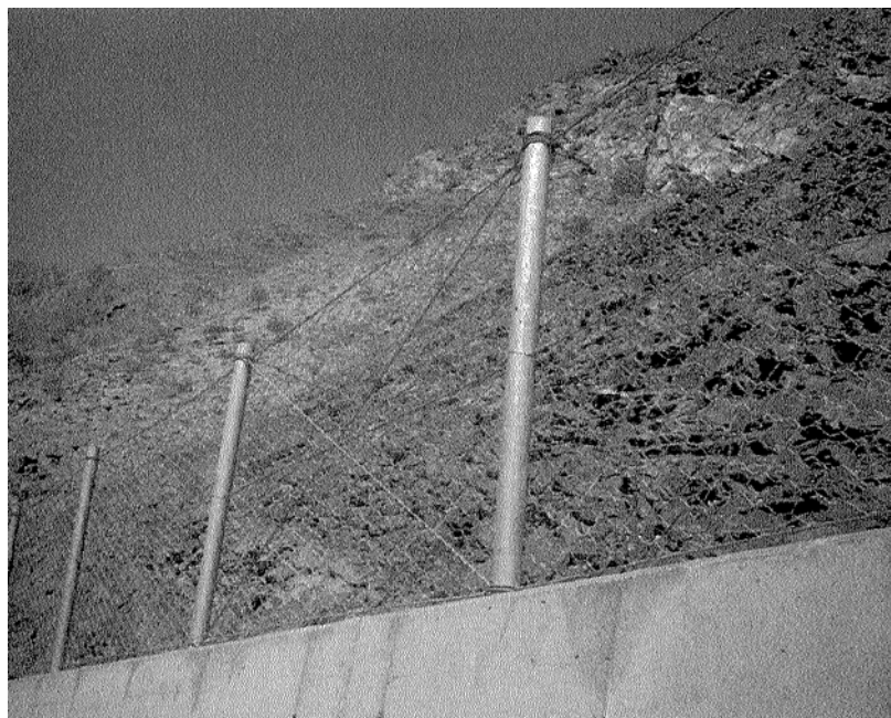
Рисунок 3.8 Пример сетчатого барьера с растяжками панелей канатами
