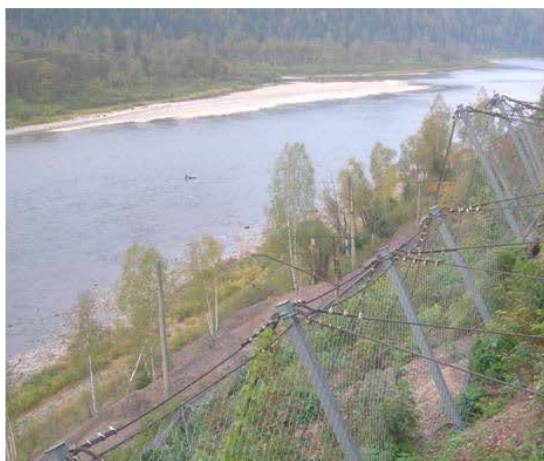
Рисунок 3.10 Пример сетчатого защитного барьера на откосе Вариант 2 НПО Геомостпроект (спроектирован как защита от снежных лавин)
